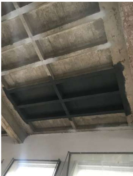
Solaio nervato in cls a vista e tinteggiato
